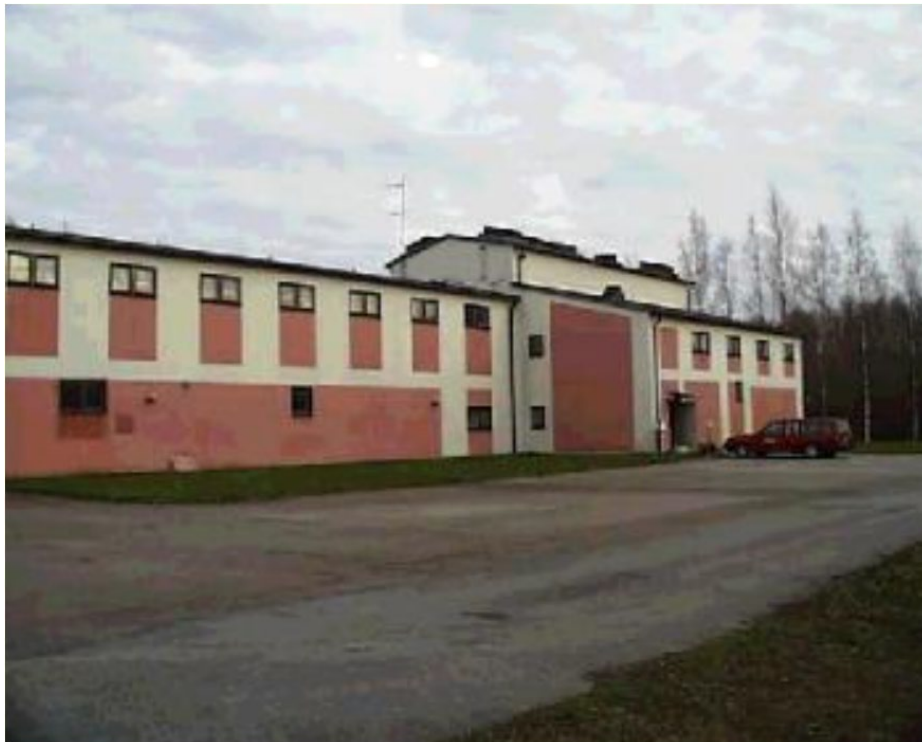
Stationsbyggnaden i Karlsborg
