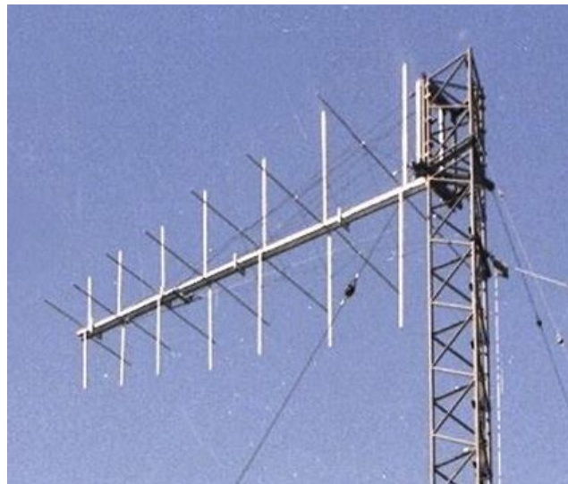
Krysslogantenn 25 – 30 MHz 10 kW
