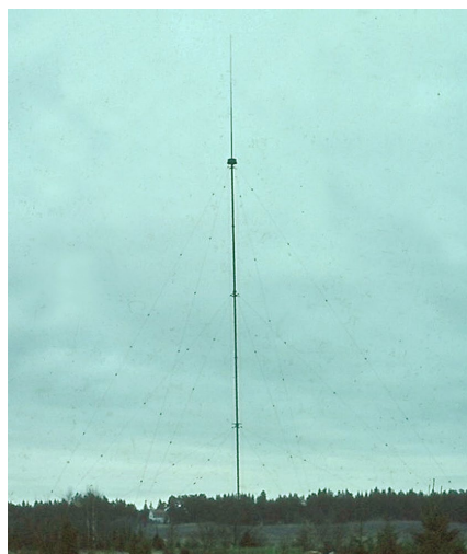
Vertikalantenn 2 – 12 MHz 10 kW
