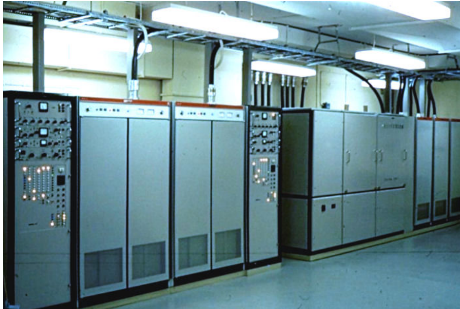
Radiosändare FMR 14B i freds Hs sändarbunker
