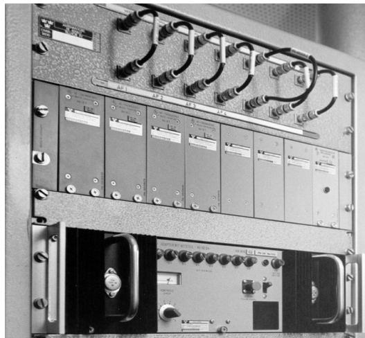
Antennförstärkare NV14 med Antennförväxel
