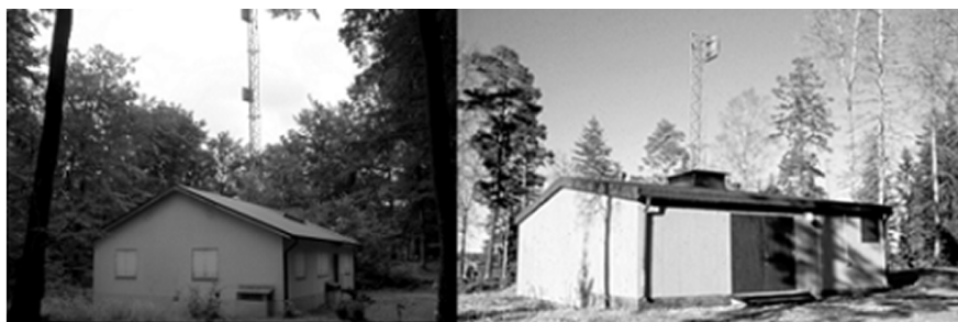
Us Mottaganläggning och Us Sändarannex
