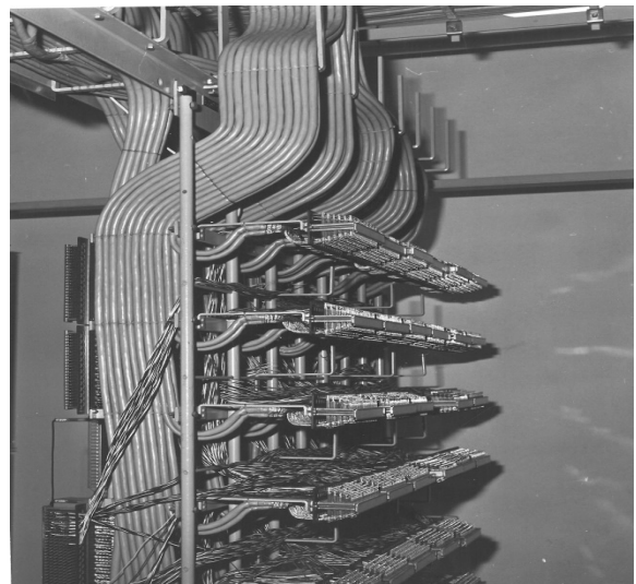
Mellan-omkopplingsstativ med kablage
