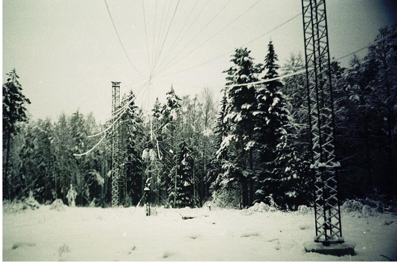
Scheuerecker dipolantenn 2 – 12 MHz 10 kW
