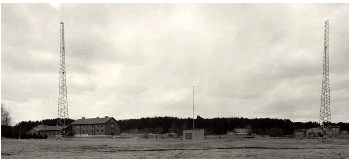
Fast Markradio typ 1, Stationshus med KV-antenn & LV-antenn Bilden är tagen vid F2. Th om vänstra långvågsmasten syns Kasern 8 och vaktbyggnaden.
